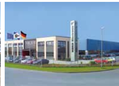
Fabricação de inversores
