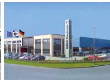
Fabricação de inversores
