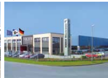
Fabricação de inversores
