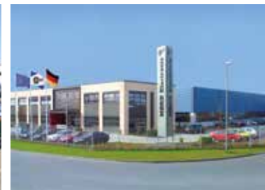
Fabricação de inversores
