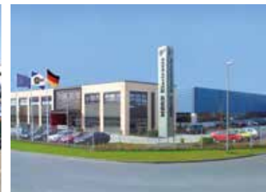
Fabricação de inversores
