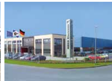
Fabricação de inversores
