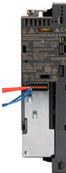
Fissaggio delle connessioni (terza mano)
