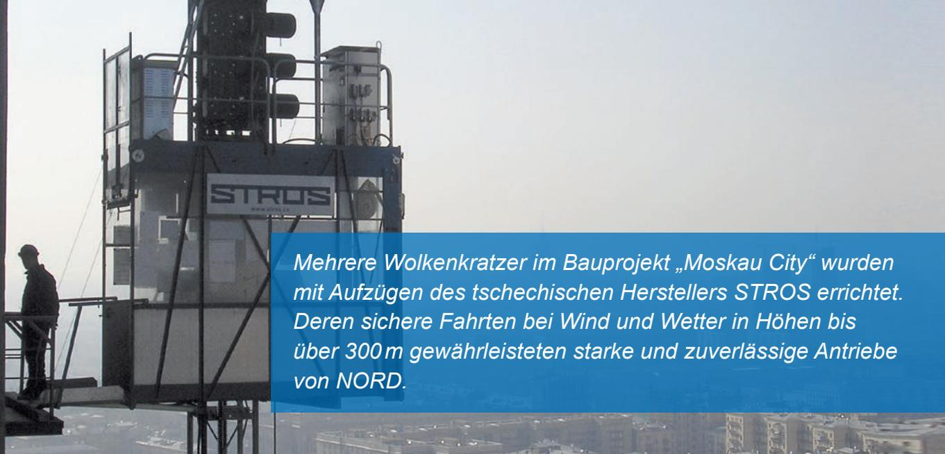
*Mehrere Wolkenkratzer im Bauprojekt „Moskau City“ wurden mit Aufzügen des tschechischen Herstellers STROS errichtet. Deren sichere Fahrten bei Wind und Wetter in Höhen bis über 300 m gewährleisten starke und zuverlässige Antriebe von NORD.*
