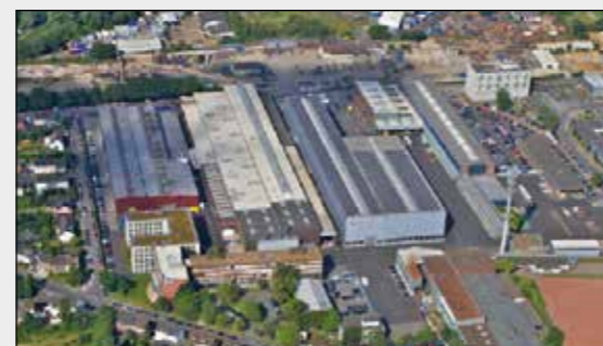
SMS group GmbH, Standort Mönchengladbach (Deutschland)
