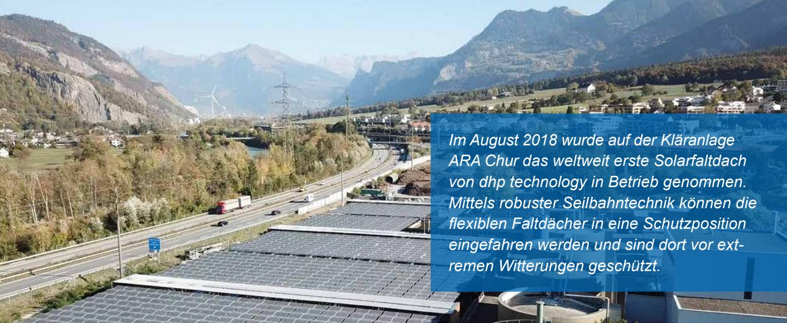
*Im August 2018 wurde auf der Kläranlage ARA Chur das weltweit erste Solarfaltdach von dhp technology in Betrieb genommen. Mittels robuster Seilbahntechnik können die flexiblen Faltdächer in eine Schutzposition eingefahren werden und sind dort vor extremen Witterungen geschützt.*
