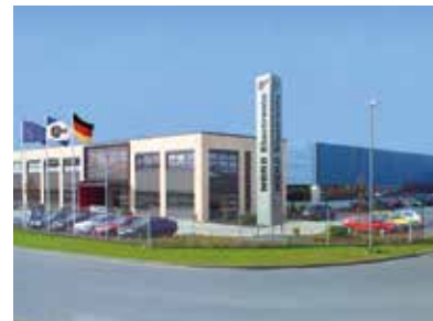
Fabricação de inversores
