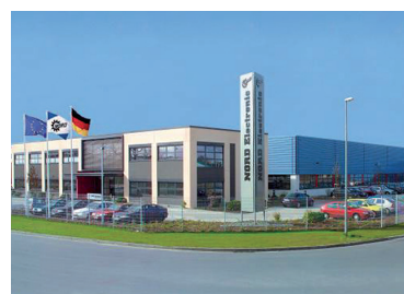
Fabricação de inversores
