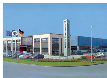
Fabricação de inversores
