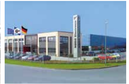
Fabricação de inversores
