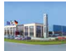
Fabricação de inversores
