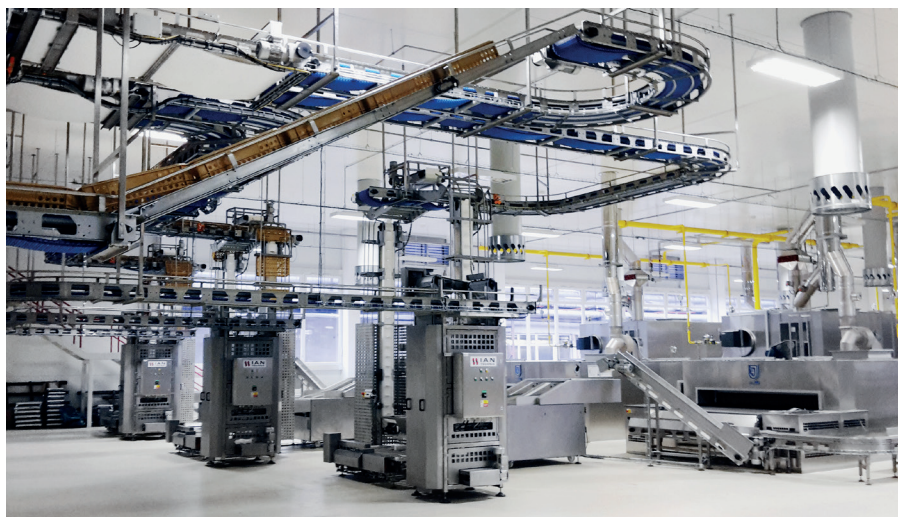
Dopravníkové systémy a stroje těsně za pecí
