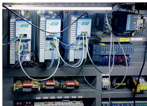
Měniče NORD: Polohovací typ SK540E pro pojezd přesuvny doplňují standardní typy SK500E pro příčný pojezd.
